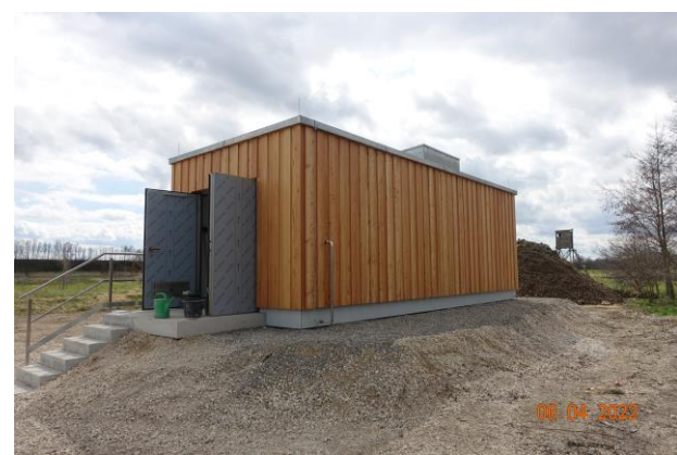
Ansicht Technikgebäude Brunnen 6
