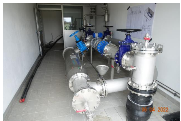
Ansicht Brunnenstube Brunnen 6 (Bauphase)
