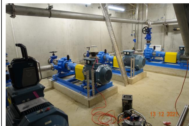
Ansicht Pumpenkeller (Bauphase)
