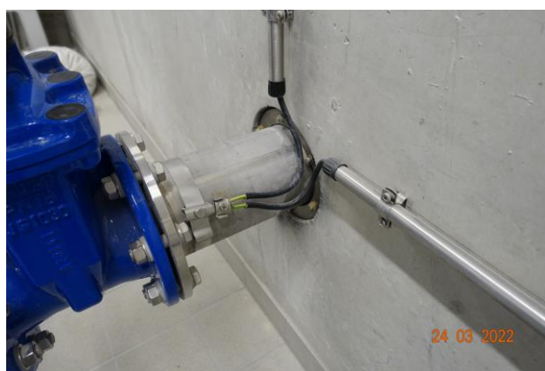
Detail: Anschluss Potentialausgleich
