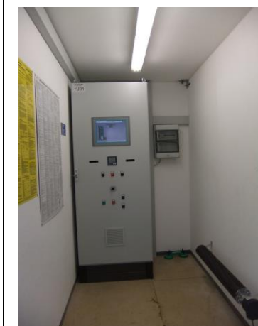
Schaltanlage und Steuerung
