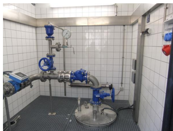
Detail: E-Installation Brunnenstube – Meßtechnik
